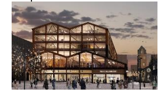
Hus 06 Stationen, Slakthusområdet
