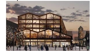
Hus 06 Stationen, Slakthusområdet
