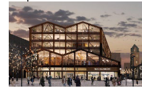
Hus 06 Stationen, Slakthusområdet
