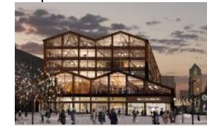
Hus 06 Stationen, Slakthusområdet
